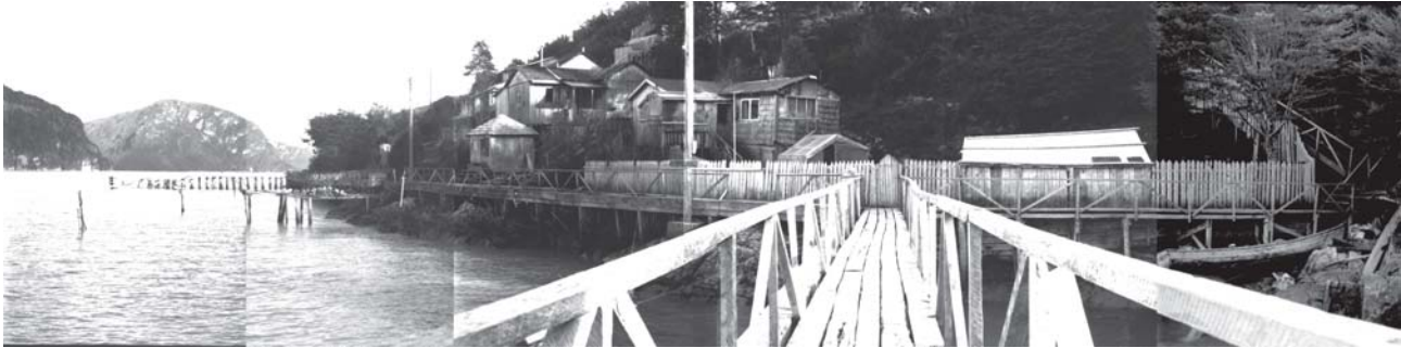
Pasarela de Ciprés en Rincón Bajo (Galle, 2000)
