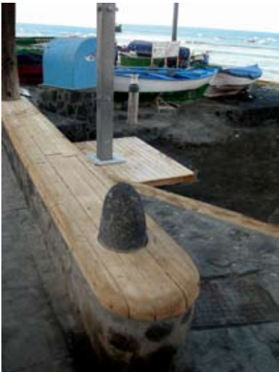
Entablado de iroko sobre murete en Playa Chica. Las tablas, de 8 cm de grueso, van encoladas sobre una capa de hormigón y se unen entre sí con ranura y lengüeta
