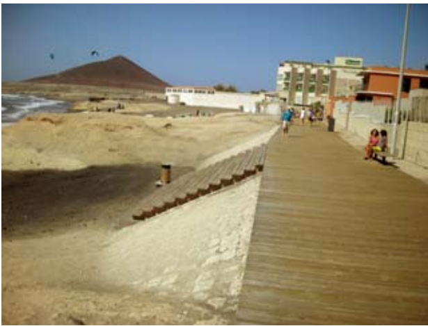
Talud natural revestido de piedra de tosca bajo el Paseo de tablas
