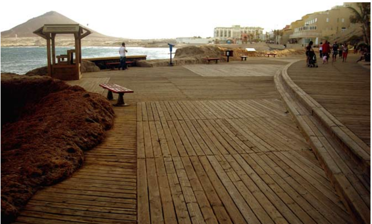
Encaje del entablado en el Paseo marítimo de El Médano. Detalles de encuentro con los bordes, cambio de dirección del entablado y resolución de los escalones
