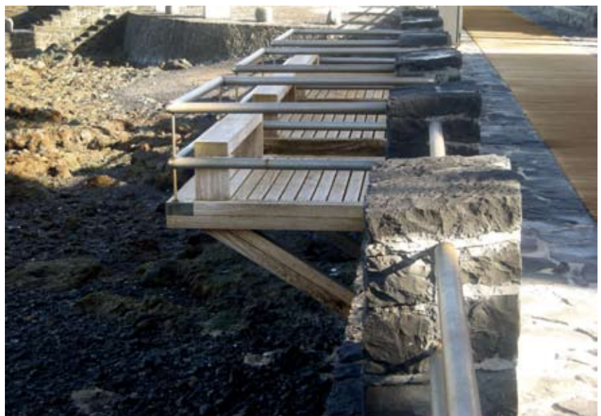
Vista lateral de los tres voladizos para el descanso o la pesca. Son de grandes secciones de iroko
