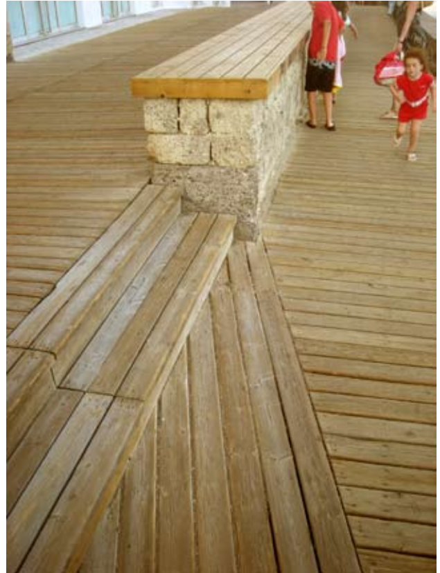
Ampliación del Paseo en solarium. Bancada sobre murete de roca
