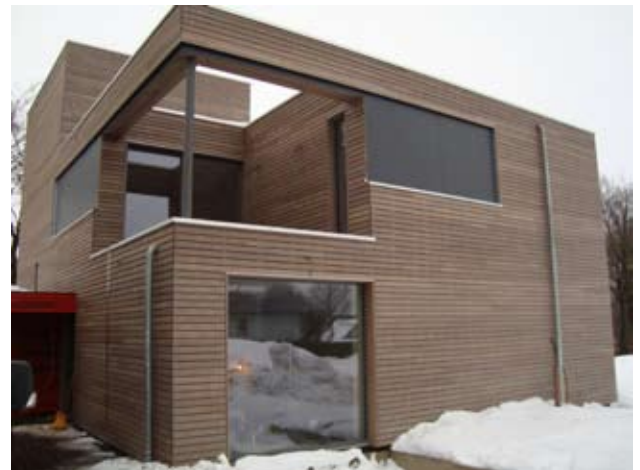
Casa pasiva en Bélgica: Madera: Cedro rojo de Canada. Perfil: rombo 18 x 90 mm, Acabado: Infineo Aceitado Natural "Gris 102"
