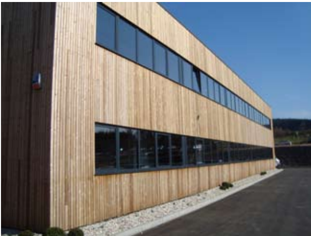
Nave industrial en Bélgica. Lama de 19 x 65 mm. de abeto termoestabilizado o termotratado. Superficie con veta resaltada y acabado aceitado anti UV
