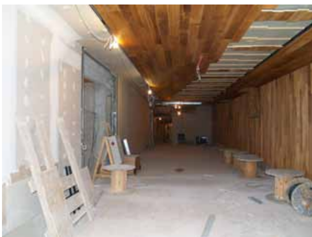
Detalle de la colocación del techo suspendido de la sala de exposiciones
