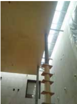
Sistema de colocación del del forro circular de los pilares
