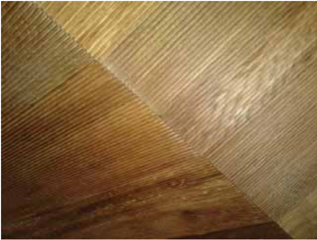
Detalle del encuentro de paneles ranurados de roble (encuentro de zanca y descansillo)
