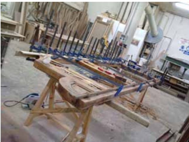
Restauración de la puerta principal, de madera de cerezo
