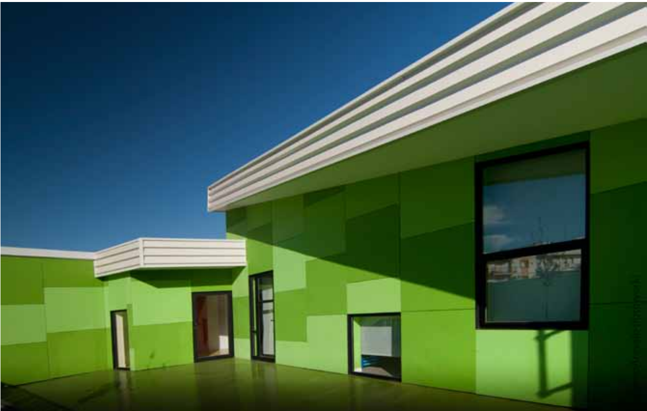
Fachadas resueltas con tableros de madera-cemento coloreadas
