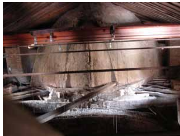
Colegio Caracciolo en Alcalá de Henares (Madrid)
