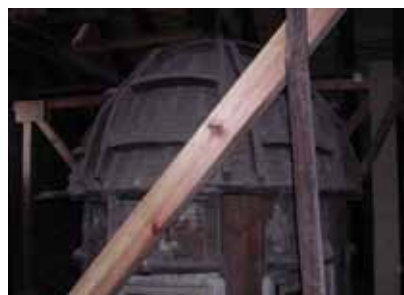
Linterna de la iglesia de San Antón (Madrid), con cupulin encamonado sujeto por medio de cuerdas de una viga superior.
