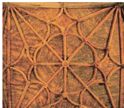
Bóveda de nervaduras de la iglesia de San Andrés de Ibarangelua (Vizcaya) AITIM
