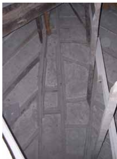
Iglesia de San Antón Encuentro entre dos bóvedas encamonadas en la zona del crucero de la iglesia de San Antón (Madrid). Se observa que las cerchas se cuelgan de las vigas madres, además del detalle de la formación de la cercha con camones solapados y ensamble a media madera.
