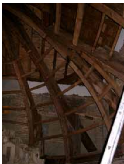
Iglesia de San Agustín (Madrid) Cerramiento de caña en la reconstrucción de un tramo de la bóveda encamonada de la iglesia San Agustín en Talavera la Reina (Toledo).
