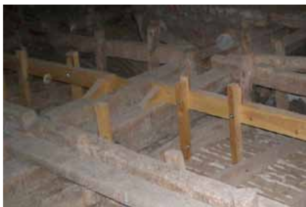
Torija (Guadalajara). Foto: Felix Lasheras Bóveda encamionada en la iglesia de Torija (Guadalajara)
