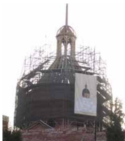
Cubierta de la capilla de San Juan de la Penitenciaría en Alcalá de Henares (Madrid), antes de colocarse los pares curvos del borde poligonal.
