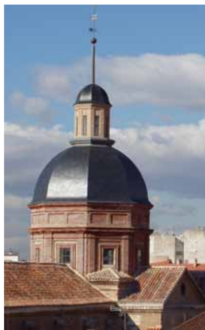
Cubierta de la capilla de San Juan de la Penitenciaría en Alcalá de Henares (Madrid) una vez finalizados los trabajos de reconstrucción.
