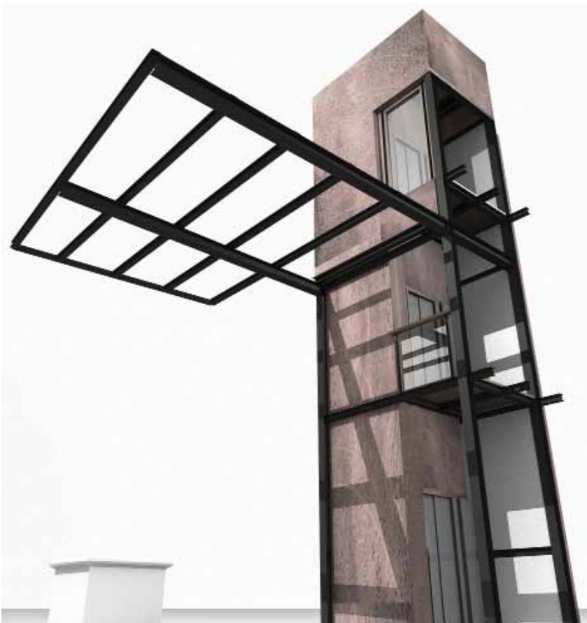
La nueva estructura cumple una doble función: alojar el ascensor y cubrir el patio mediante una estructura en voladizo, sin apoyos en su perímetro.
