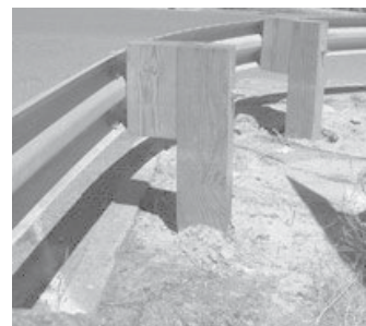
Poste de madera y valla metálica
