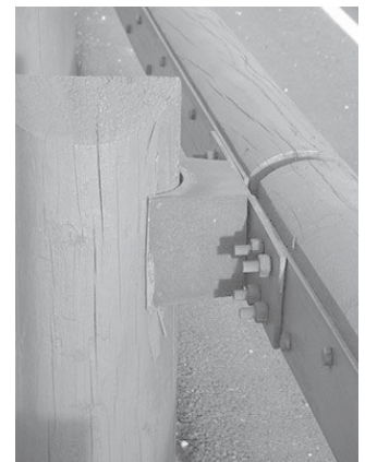
Poste y viga de maderaA
