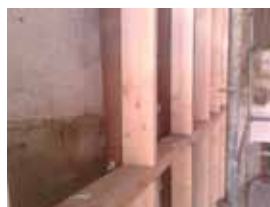
Aislamiento de la medianera
