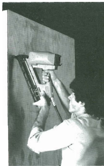
Fabricación de contenedores de tablero contrachapado reforzado con madera maciza.
