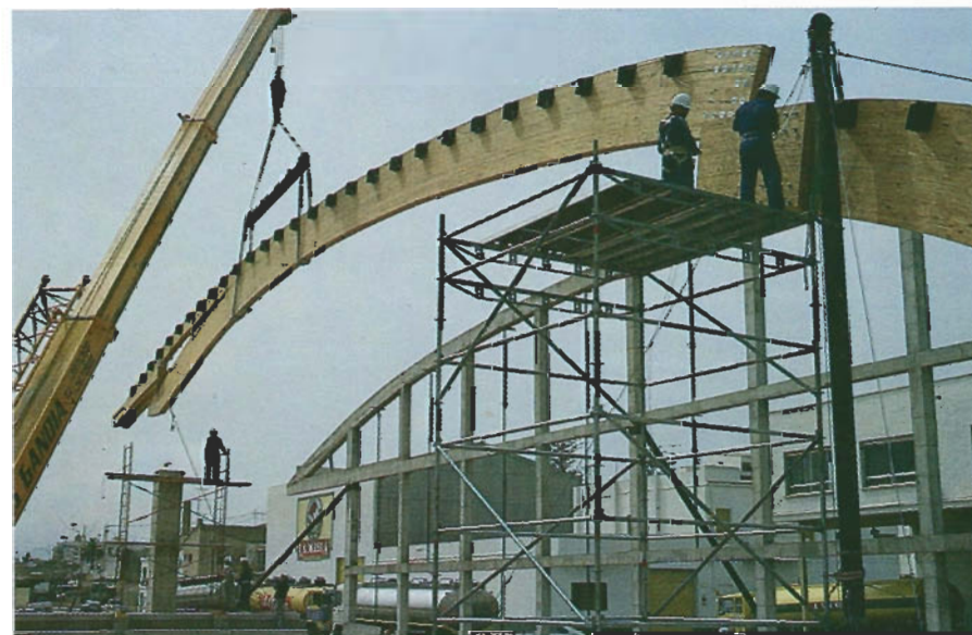
Proceso de Montaje
