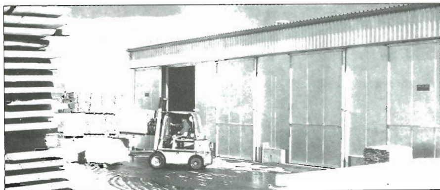
Ilustración 1: Instalación de secado tradicional BOLLMANN.
