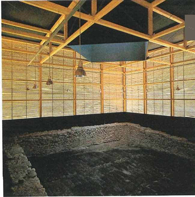
Cerramientos de protección de ruinas arqueológicas
