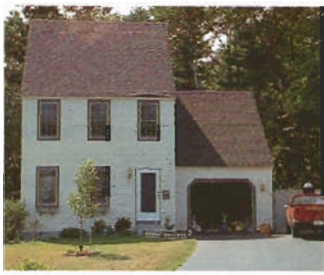
Viviendas de tipo medio. Esta vez es de paneles prefabricados.
