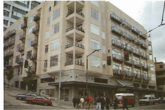
Edificio de seis plantas en Seattle (Wa), construido en madera con sistema de entramado y tableros.
