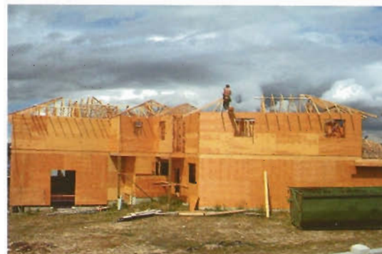
Construcción tradicional de entramados y contrachapado estructural.
