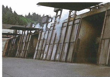
Cámaras de vaporizado.
