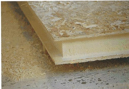
Rebajes para la unión de paneles.
