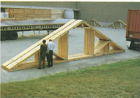
Las cerchas, y otros componentes de la vivienda se subcontratan fuera de WPH.
