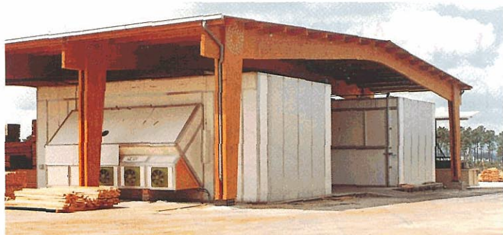
Cobertizo de madera laminada y secaderos de bomba de vacío, (60 m 2 ).
