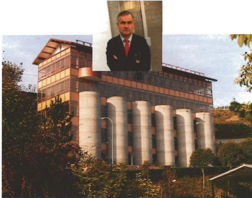
Sermusa. Edificio en construcción para dar lugar a Servicios de Muebles Hermida I y Hermida II, oficinas y exposiciones para locales.
