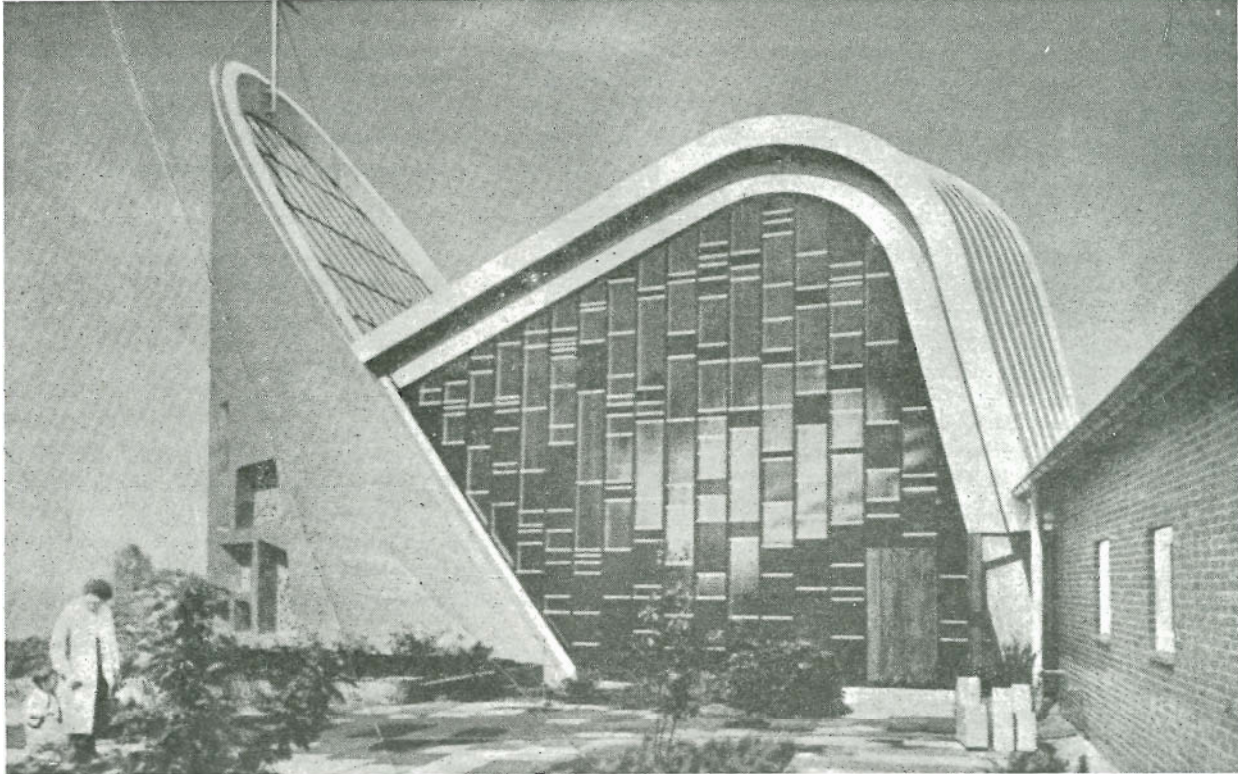
La estructura soporte es de madera laminada.
