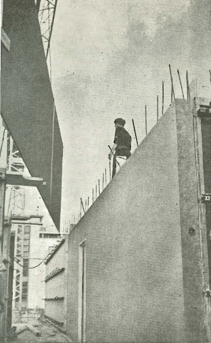
La superficie del hormigón queda completamente lisa cuando se emplea encofrado de tablero chapado.
