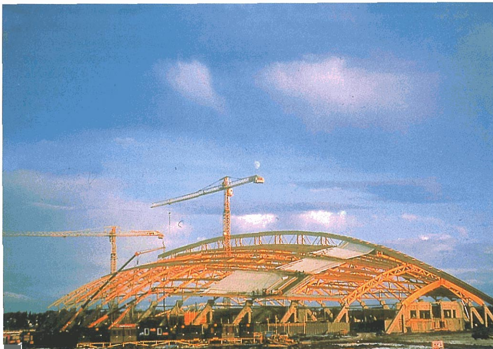
El Pabellón Olímpico de Lillehammer de 1994 requirió la construcción de complejos subproyectos en muy cortos periodos de tiempo. El así llamado 'barco vikingo' para las pistas de patinaje ha sido considerado como el edificio emblemático de los Juegos. Los grandes arcos de madera laminada del Hákon Hall diseñadas por Østgaard Arkitekter y los dell Olympic Cavern Hall en Gjøvik de Moe-Levorsen continúan estudiándose por parte de los técnicos
