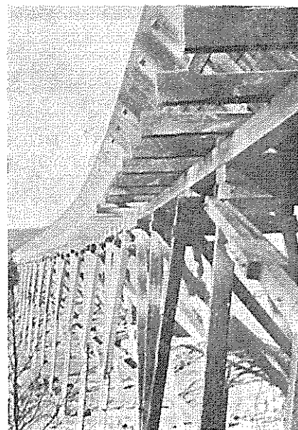
Acueducto para el paso de troncos en el dique de la Central Eléctrica de Hjalta, en el norte de Suecia. Tiene 6,3 km. de longitud y fue construido en 1947-49. En la construcción se emplearon alrededor de 170.000 pies cúbicos de madera.
