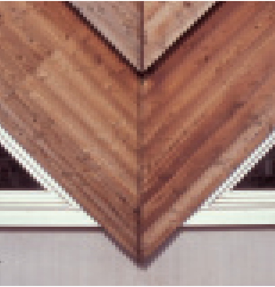
DETALLE DE LA FACHADA DE LA ANTIGUA FÁBRICA DE MADERA LAMINADA
