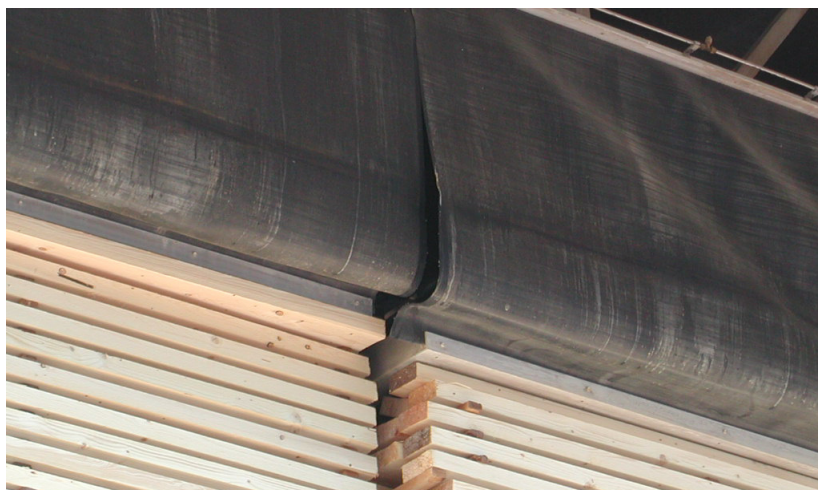
DETALLE DE LA PRENSA DE TECHO PARA REDUCIR LA DEFORMACIÓN EN EL SECADO
