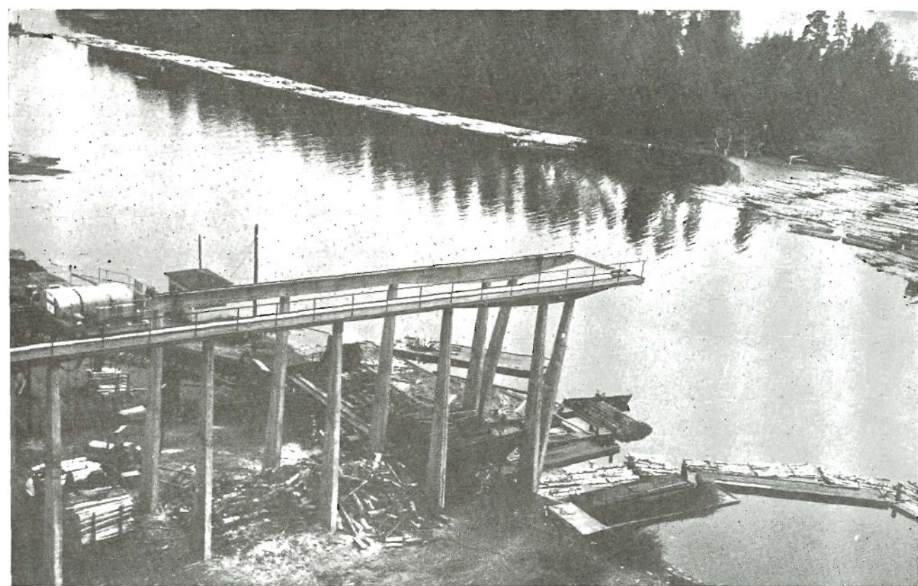
Puente grúa utilizado para extraer la madera flotante del lago y depositarla sobre las cadenas de alimentación de la fábrica de tableros de fibras, en Savonlinna.
