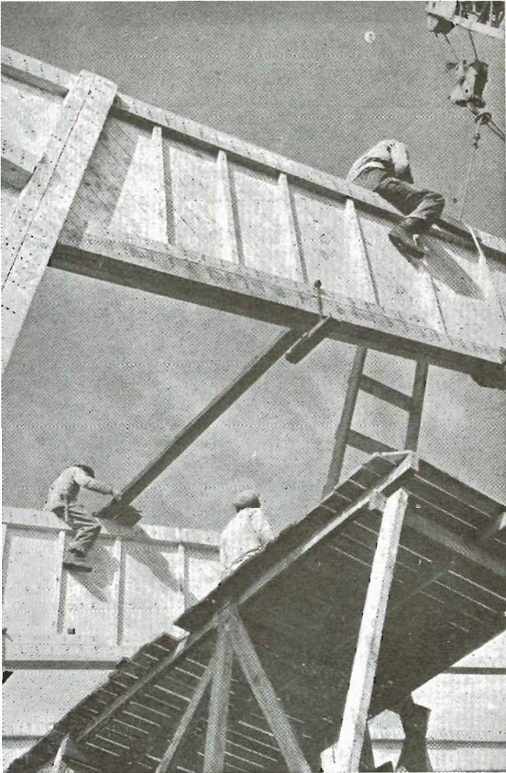
Colocación de las vigas finlandesas de madera clavada.
