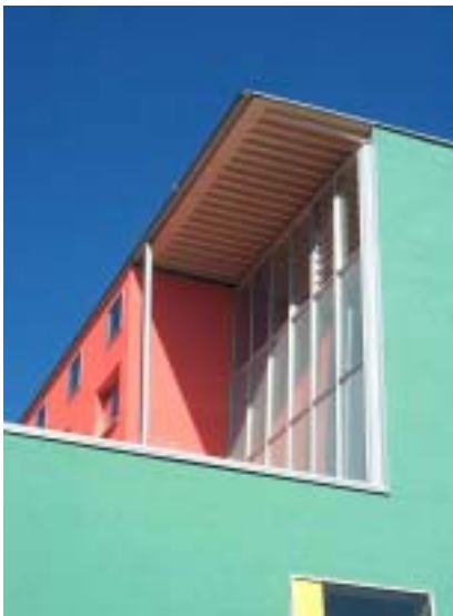
Empleo de Kerto en forma de perfiles (viguetas) y tableros en la residencia de estudiantes de Ausfuehrung (Alemania)
