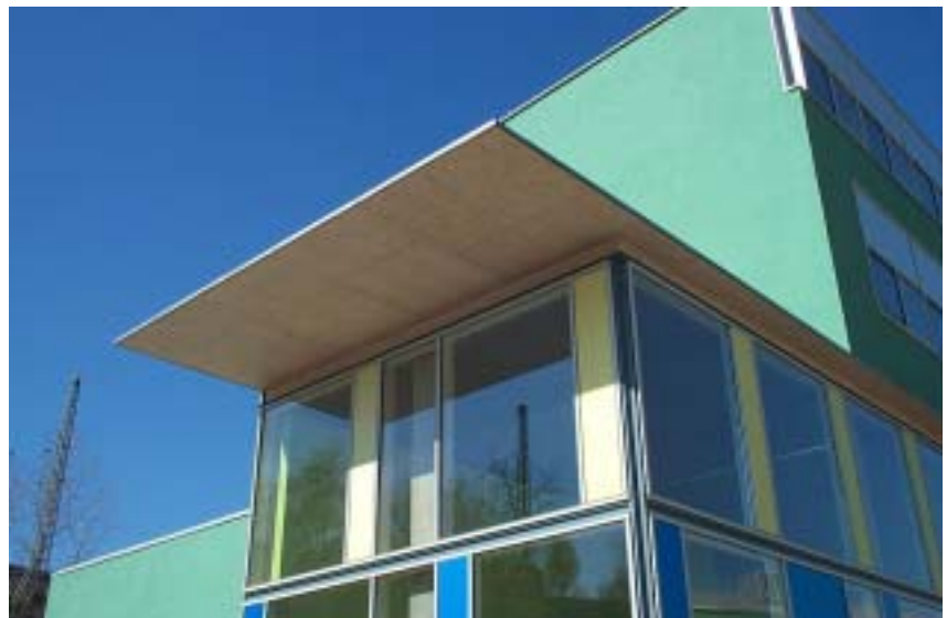
Empleo de Kerto en forma de perfiles (viguetas) y tableros en la residencia de estudiantes de Ausfuehrung (Alemania)
