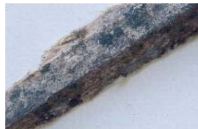
FOTO 3 (MOHOS Y HONGOS)
