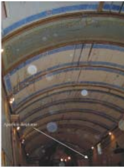
Fig. 2. Interior. [foto RNP]
