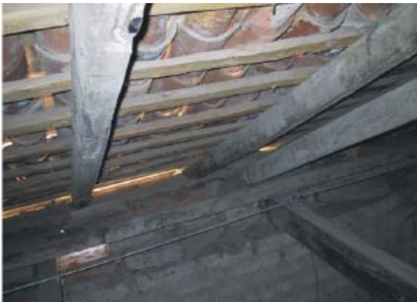
Fig 10. Interior techumbre. Tijeras y soleras de apoyo [foto RNP]
