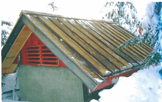
ENSAYOS DE CAMPO CON MADERA DE PINO TRATADA
