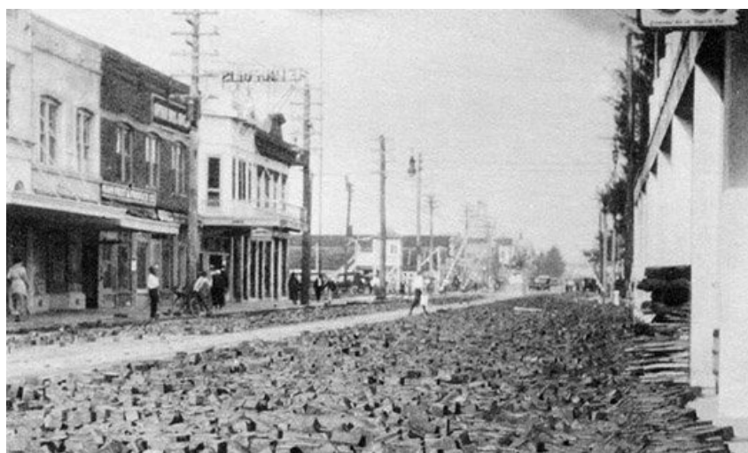
Un adoquinado de madera en deficiente estado de instalación que se acaba levantando. Miami (EEUU)
