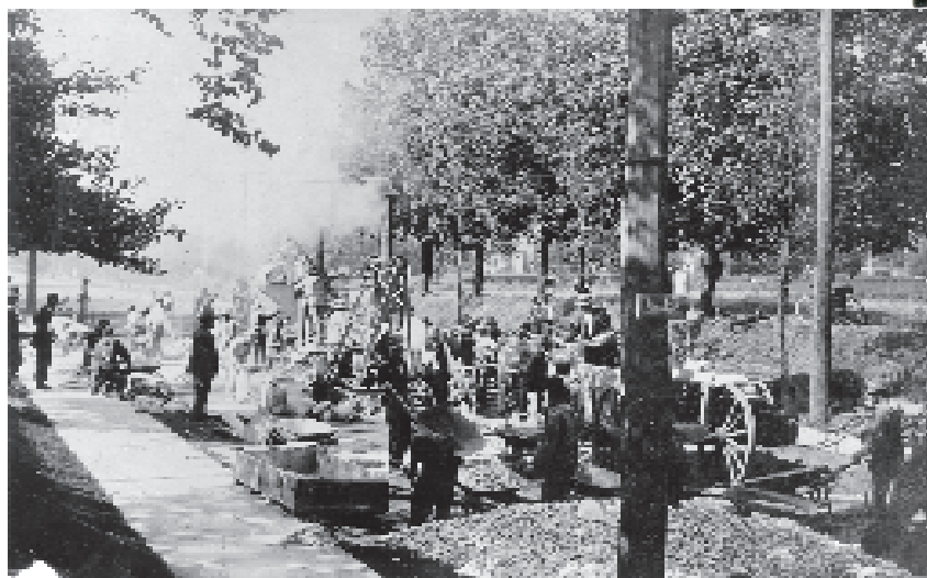
Adoquinado de madera en ejecución
