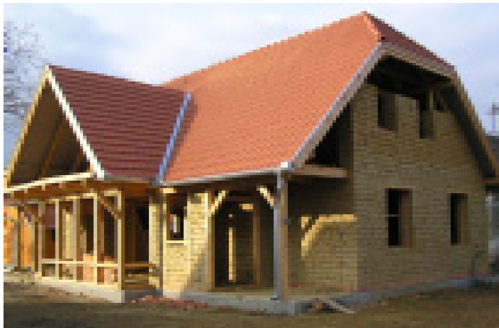
Fig. C1 – vista general vivienda.
