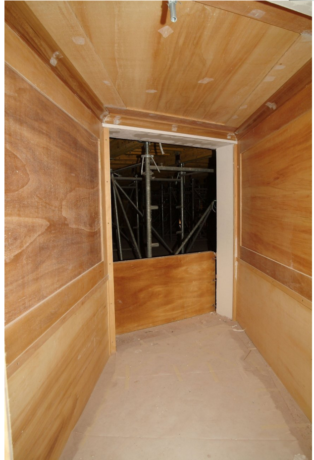
Cantiere Ricostruzione Teatro la Fenice ( palchi 1° piano ) FOTO (C) Michele Crosera
