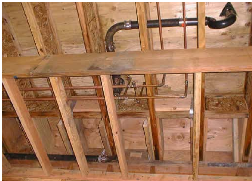
Viguetas I joist en un edificio de vivienda unifamiliar
