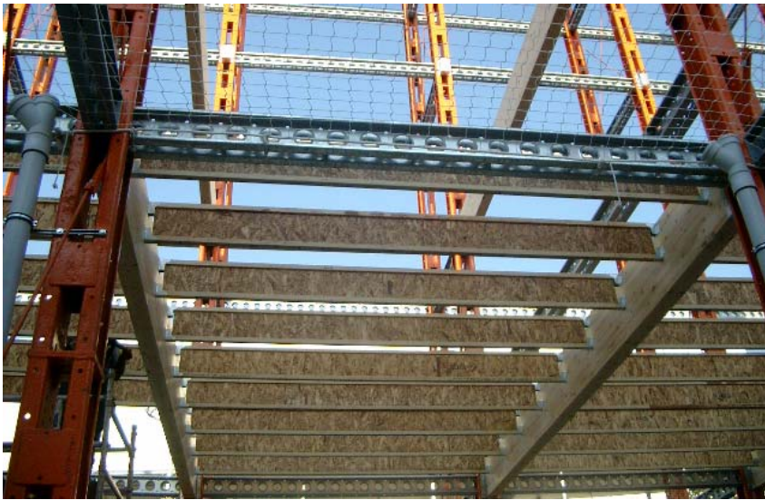
Viguetas I Joist de Weyerhaeuser en el edificio experimental Dominó 21 presentado en la feria Construtec de Madrid (octubre de 2004)
