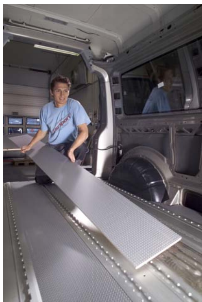
Instalación del piso de vehículos ligero con WISA-Multifloor
