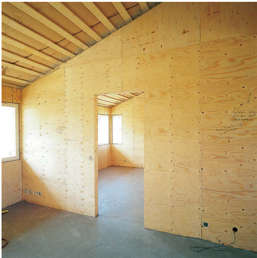
Figura 12.- Construcción con WISA-Spruce
