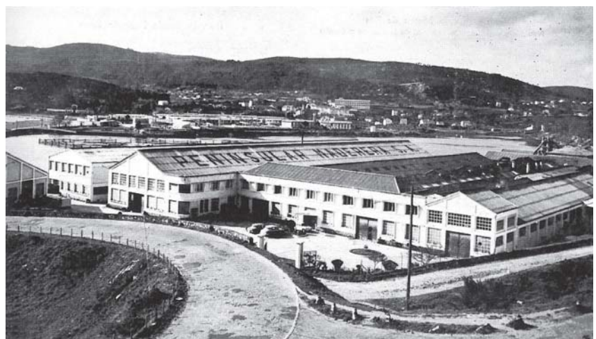
Peninsular Maderera, fábrica de puertas PENZA
