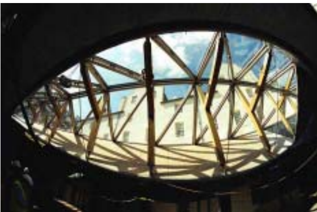
El Garden Lobby iluminado cenitalmente por 12 lucernarios con forma fusiforme, de acero y vidrio
