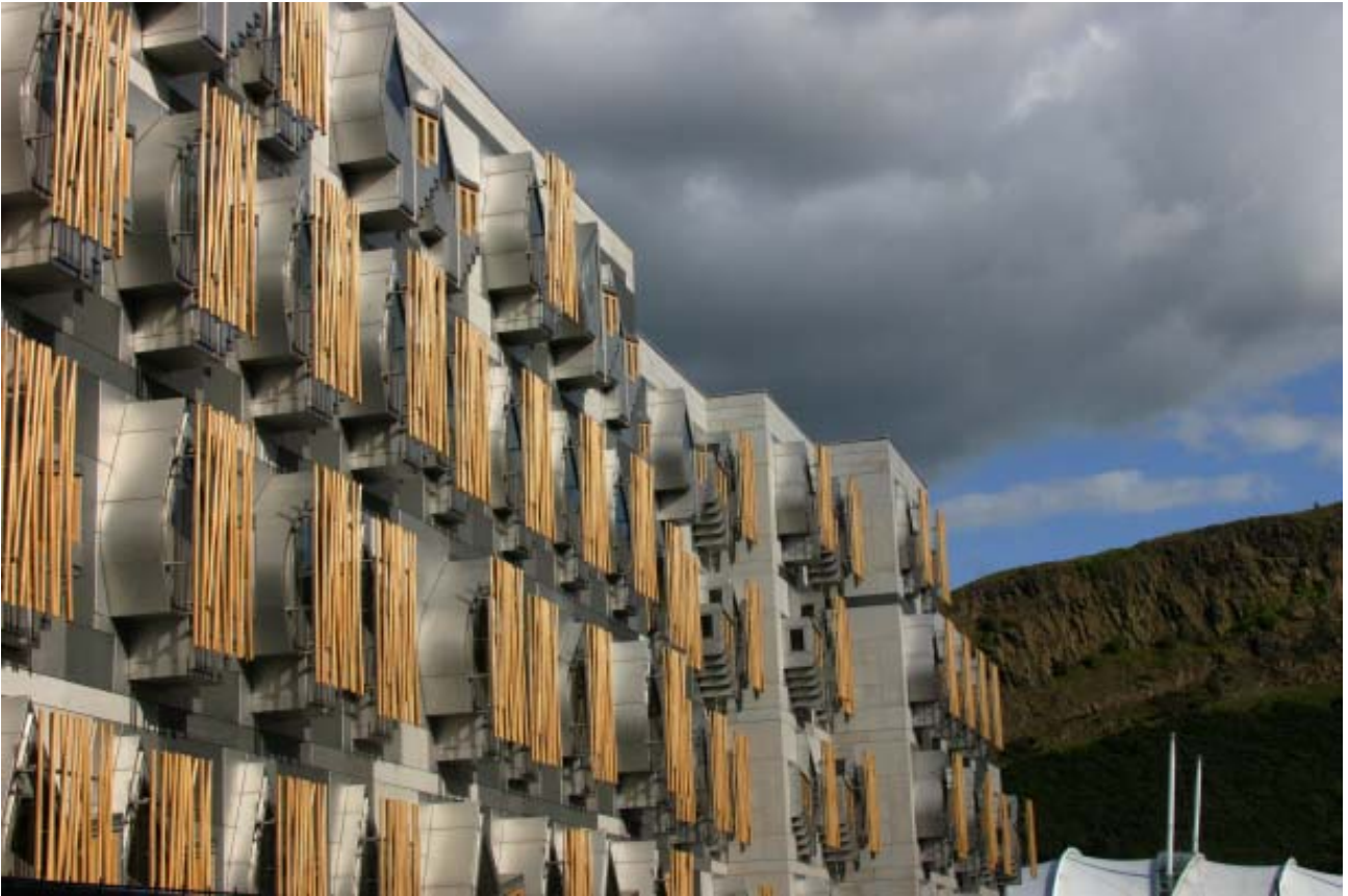
Dos aspectos de la fachada de los parlamentarios, configurada por las bay-windows
