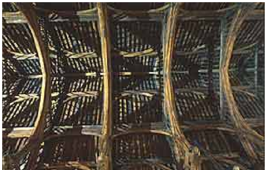
Vista del techo del Hall de Westminster desde abajo
