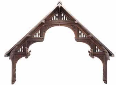
Estructura de doble hammer beam
