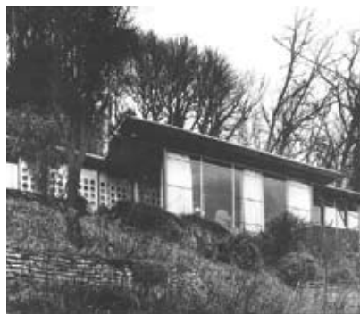
Vista del edificio desde la pendiente inferior
