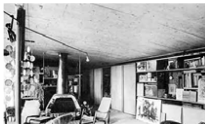
Vista del salón donde se aprecian los tableos contralaminados del techo
