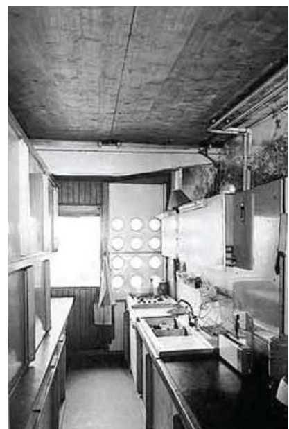
Vista de la cocina donde se aprecian bien los tableros contralaminados de cubierta
