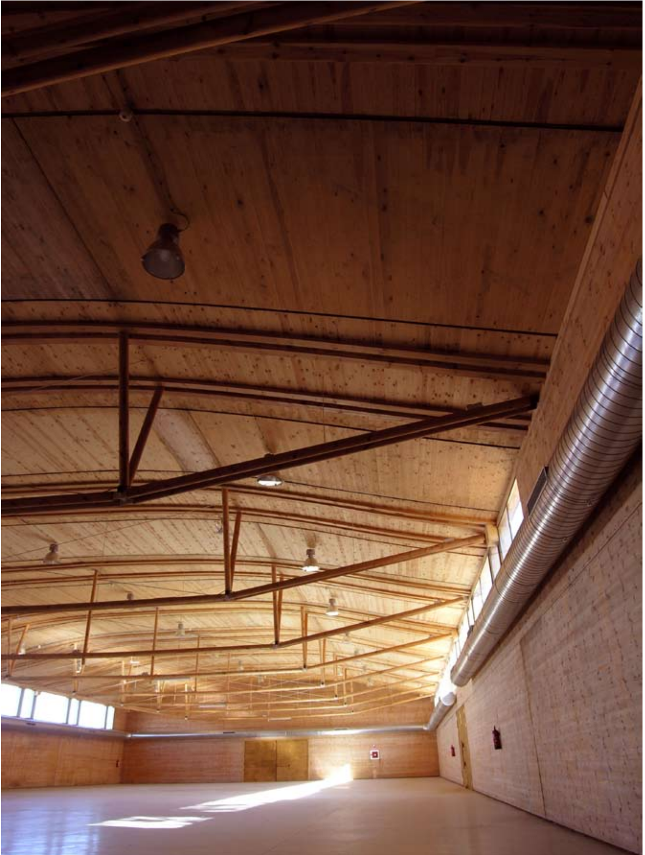
Resultado final: interior del edificio
