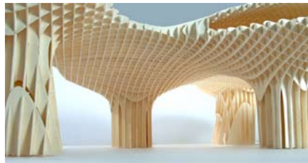
Maqueta de Metropol Parasol, que se encuentra en la Plaza de la Encarnación de Sevilla y es obra del Arquitecto Jurgen Mayer. La obra consiste en 6 torres que cubren completamente la plaza. Está toda realizada en LVL Kerto-Q. Se empieza a montar en julio de 2009 y se espera terminara a finales de 2.009
