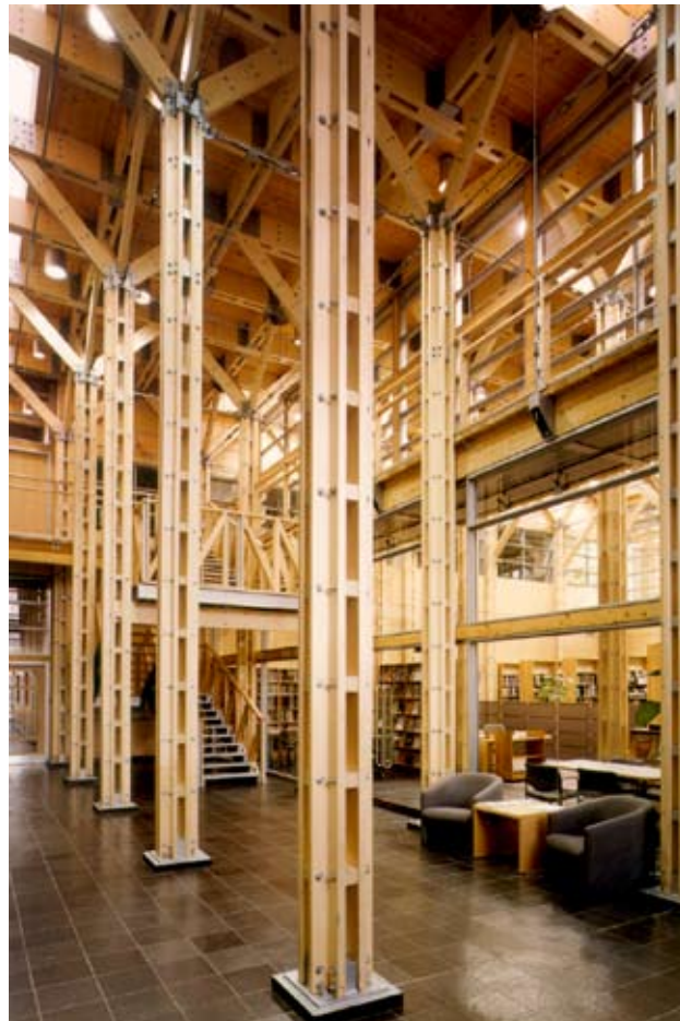
Estructura de la sede de Forintek en Quebec realizada con LVL de Aspen
