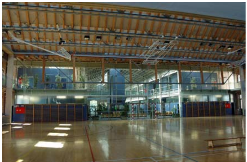
Vista de una de las canchas con el hall central y la piscina al fondo. En término medio se aprecia la gran cercha mixta colgada que separa la estructura metálica y la mixta
