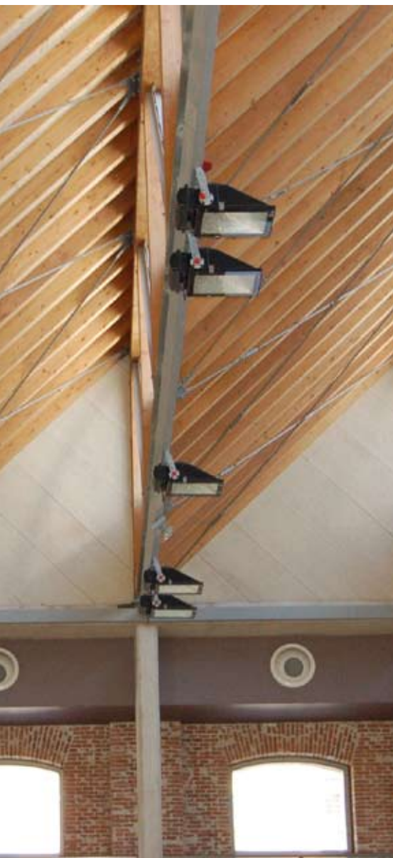
Vista de una de las canchas con el hall central y la piscina al fondo. En término medio se aprecia la gran cercha mixta colgada que separa la estructura metálica y la mixta
