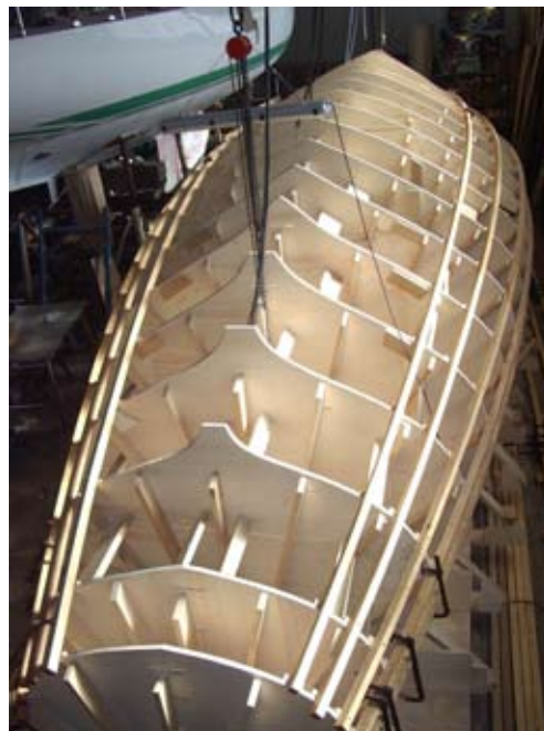
1 Gálbos realizados con un centro de trabajo de 5 ejes SCM Record 132 que, además de dar la geometría en el plano, también ha creado el ángulo de inclinación del casco, es decir, el cartabón. (foto gálbos+foto SCM Record 132)
