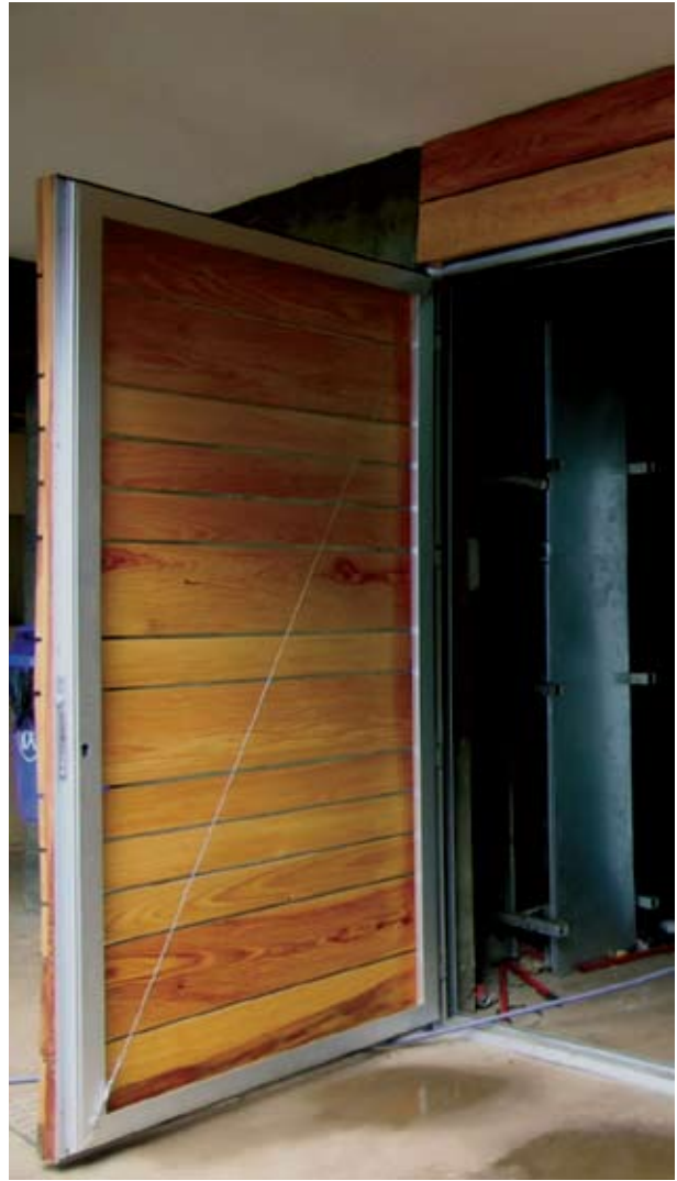
Detalle del tirante en la cara interior de la puerta
