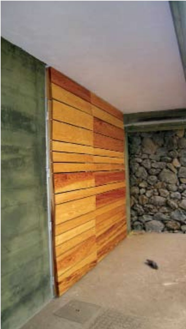
Vista lateral de la puerta donde se aprecia el facetado del entablado
