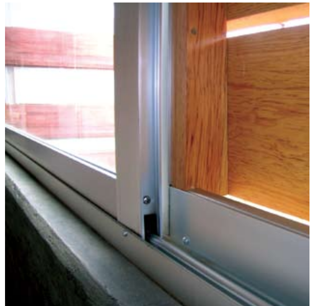
Imagen donde se aprecia el rebaje de la madera para encajar en el bastidor y fijación con tornillo de los dos bastidores
