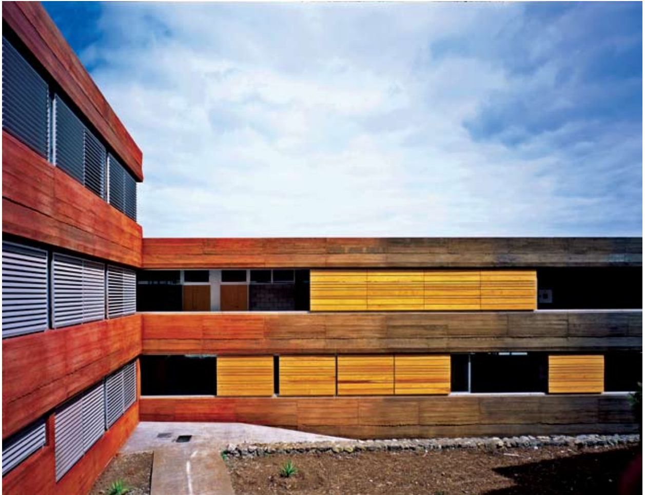
Aspecto general de unas contraventanas, alternándose con los huecos acristalados y el contraste de color entre ellas y la fachada de hormigón
