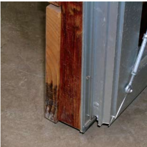
Detalle del encuentro del bastidor con el tirante y el entablado
