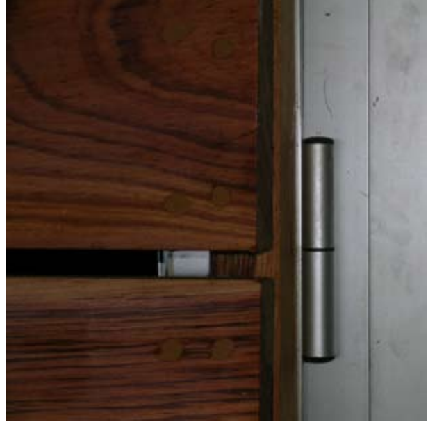
Detalle de las fijaciones de las tablas al bastidor
