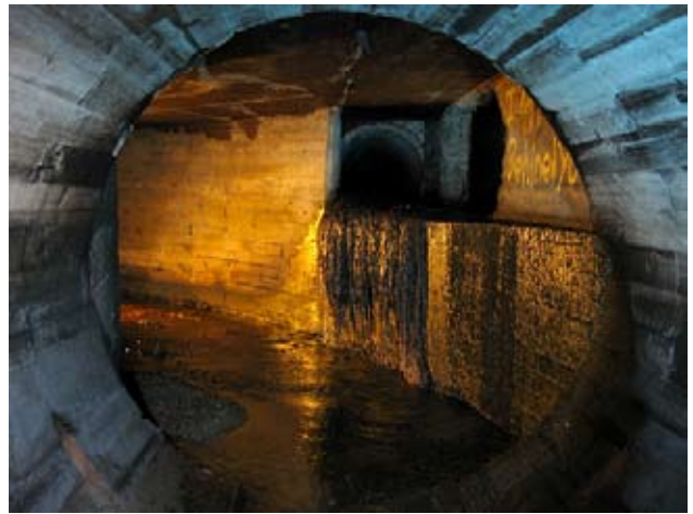
Tuberías de madera para saneamiento en Victoria (Columbia Británica, Canadá), todavía en funcionamiento
