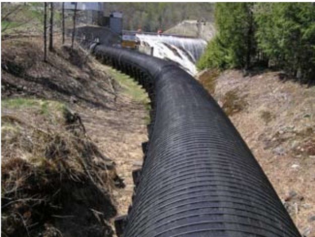
Tuberías de madera para saneamiento en Victoria (Columbia Británica, Canadá), todavía en funcionamiento
