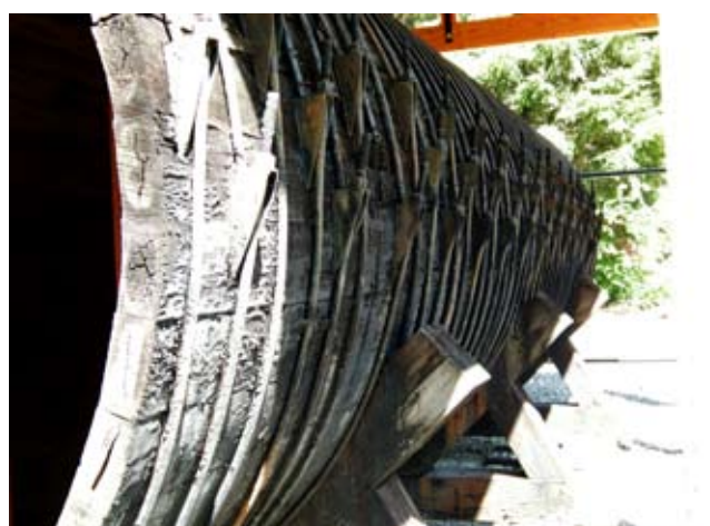
Detalle de la tubería de madera de cedro rojo que se utilizó desde 1930 hasta 1991 para llevar el agua del río Cedar a Seattle, Washington, EE.UU.. Obsérvense las bandas de metal que daba rigidez a las duelas. Se encuentra ahora en exposición en el museo Maple Valley Historical Society cerca del centro de Valle de Maple. Fotos Joe Mabel (mayo 2009)
