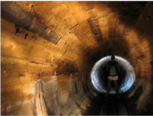
Tuberías de madera para saneamiento en Victoria (Columbia Británica, Canadá), todavía en funcionamiento
