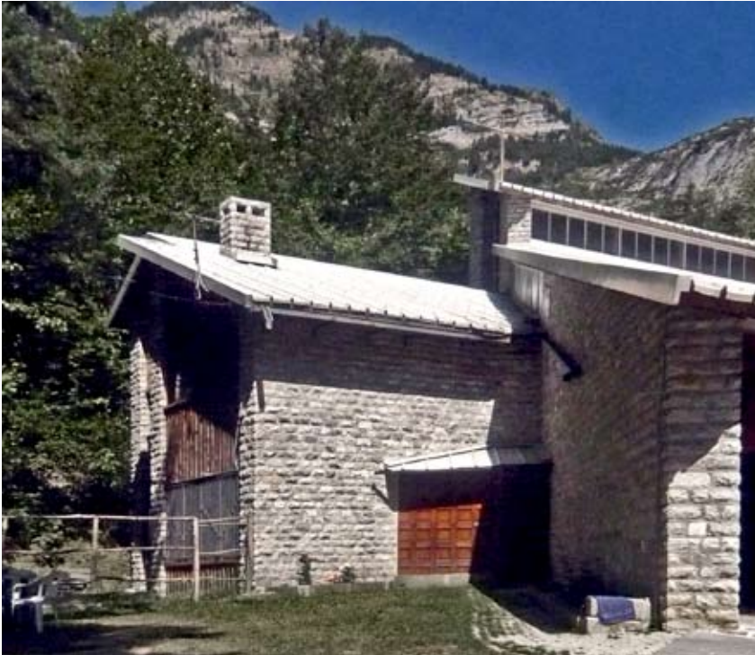
Vista de la fachada lateral de la vivienda del párroco. En planta baja una reja impide la visión de la ventana corrida de la sala. El entablado de la fachada es análogo al de la cubierta, dispuesto en la misma dirección. Ignoro si la puerta de cuarterones es un añadido posterior o se trata del reciclaje de una puerta existente.
