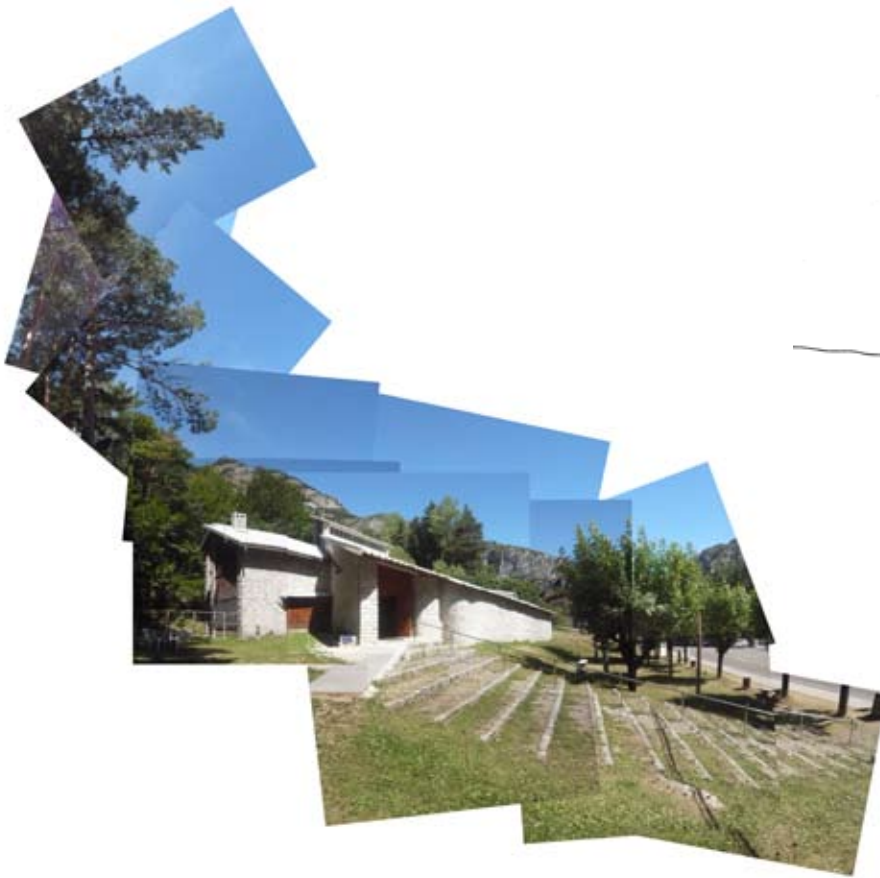
Vista exterior. Con los escalones de piedra y diversos conjuntos de carpintería de tabloncillos de pino vertical, contrastando con la masividad de los muros de mampostería y el plano blanco de la cubierta de aluminio.
