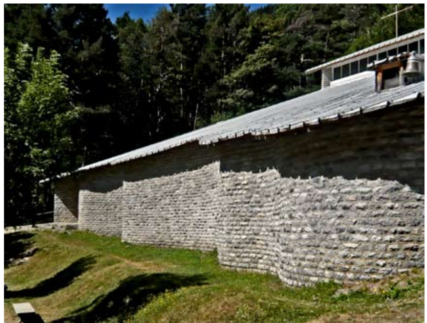
Vista exterior. Los muros macizos de mampostería completamente ciegos jugando con la pendiente natural y la cubierta de aluminio. A la derecha el lucernario del baptisterio, con la campana incorporada.
