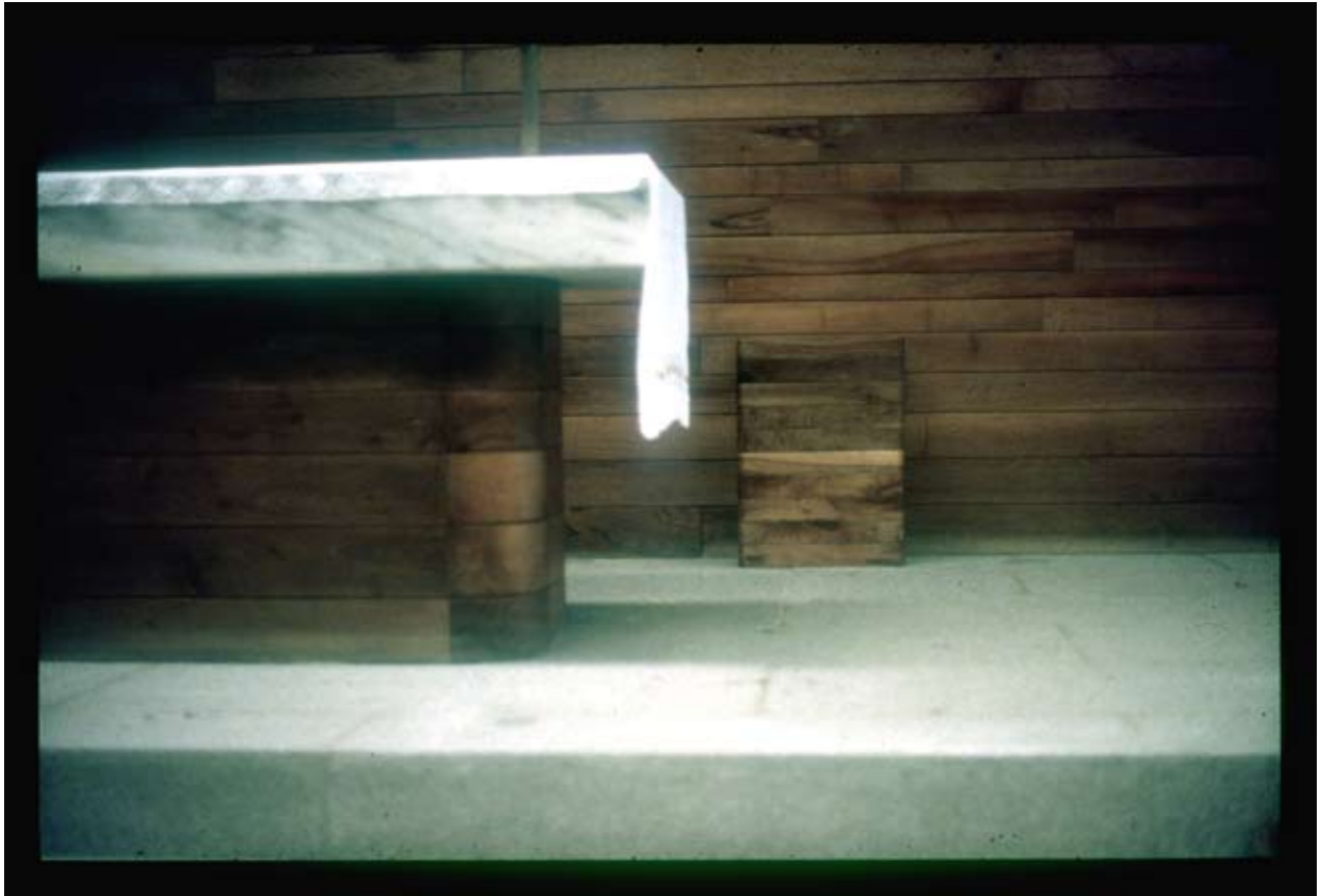
Detalles de la carpintería de la capilla del Santísimo, toda realizada en nogal, acabado con goma laca, aplicada a muñequilla. Todos diseñados por Fisac y ejecutados por Germán Larragueta (Carpintería La Navarra)
