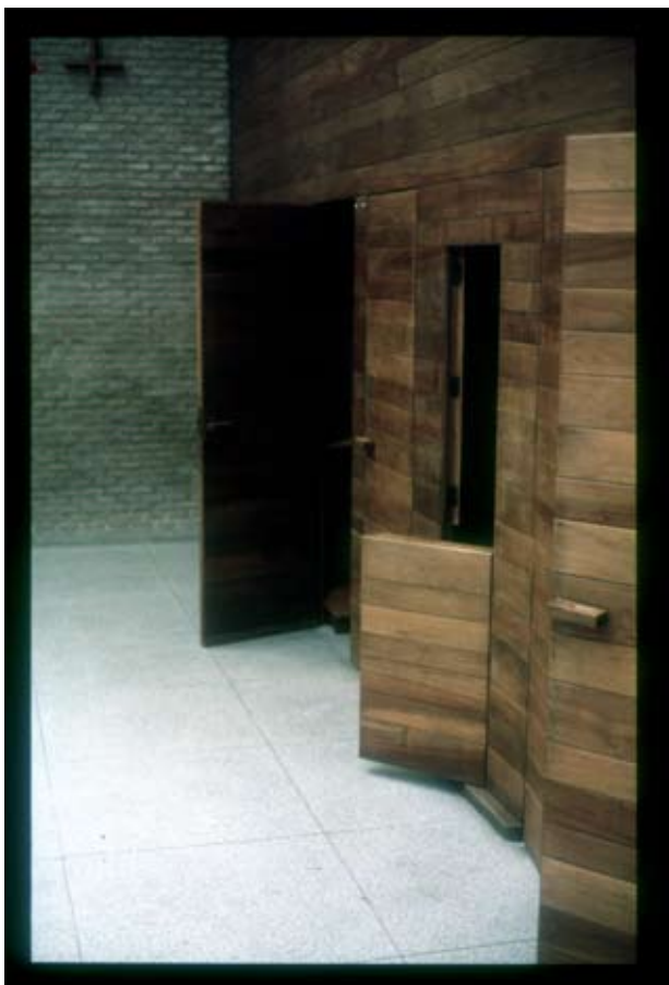
Detalles de la carpintería de la capilla del Santísimo, toda realizada en nogal, acabado con goma laca, aplicada a muñequilla. Todos diseñados por Fisac y ejecutados por Germán Larragueta (Carpintería La Navarra)
