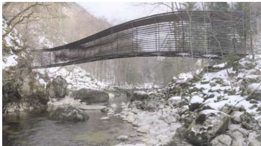
Pasarela peatonal en Boudry (Suiza, 2002)
