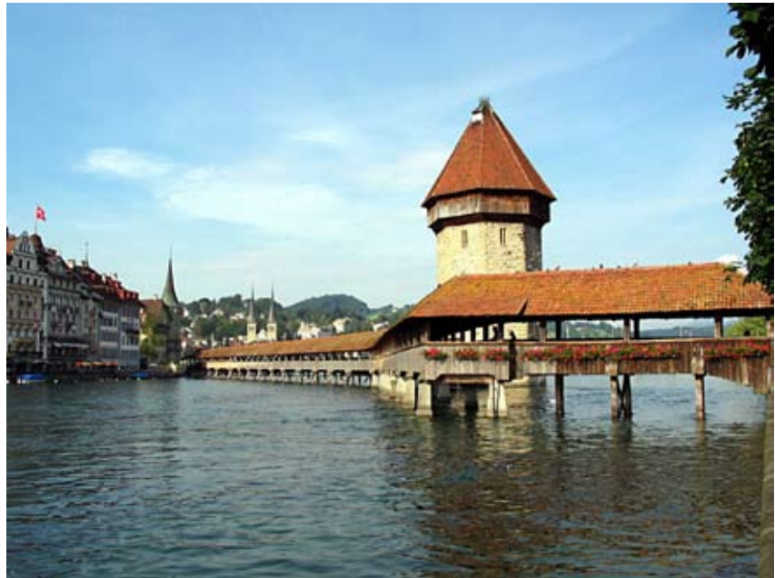
Puente peatonal cubierto Kapell en Lucerna, Suiza
