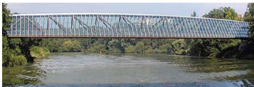
Puente peatonal sobre el río Neckar en Remseck (Alemania, 1988)
