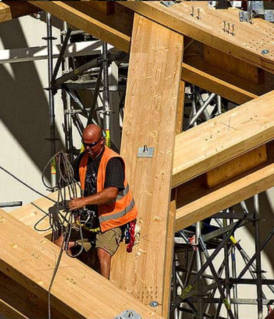
curados con pernios, apreciándose el empalme de testa
