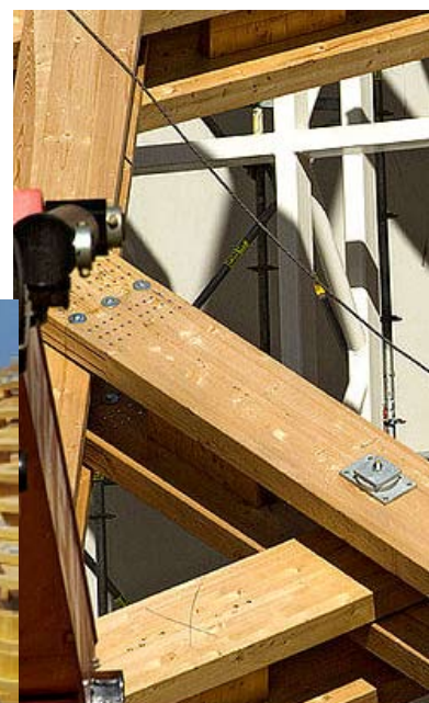
El hexágono formado, con los nudos asegurados entre las vigas
