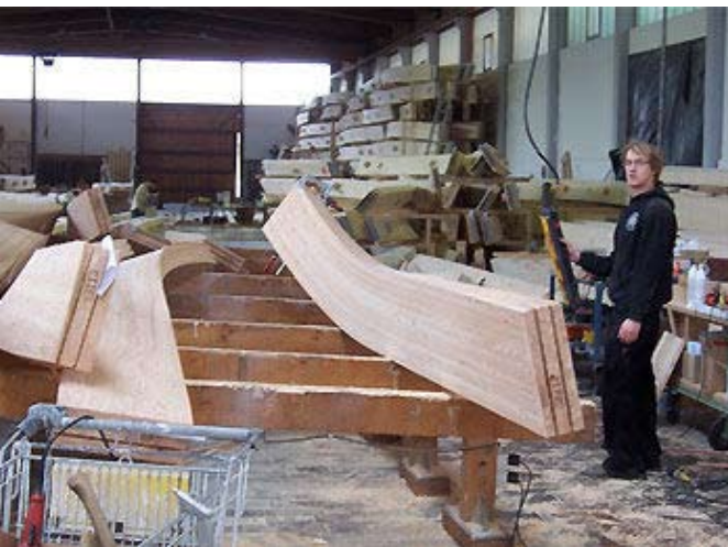
Fabricación de las piezas de las vigas
