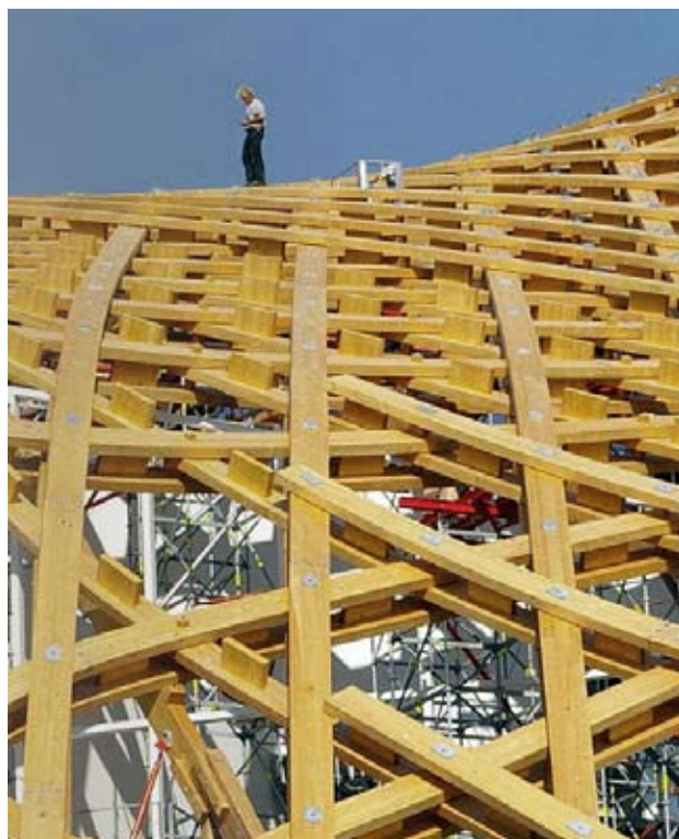
El hexágono formado, con los nudos asegurados entre las vigas
