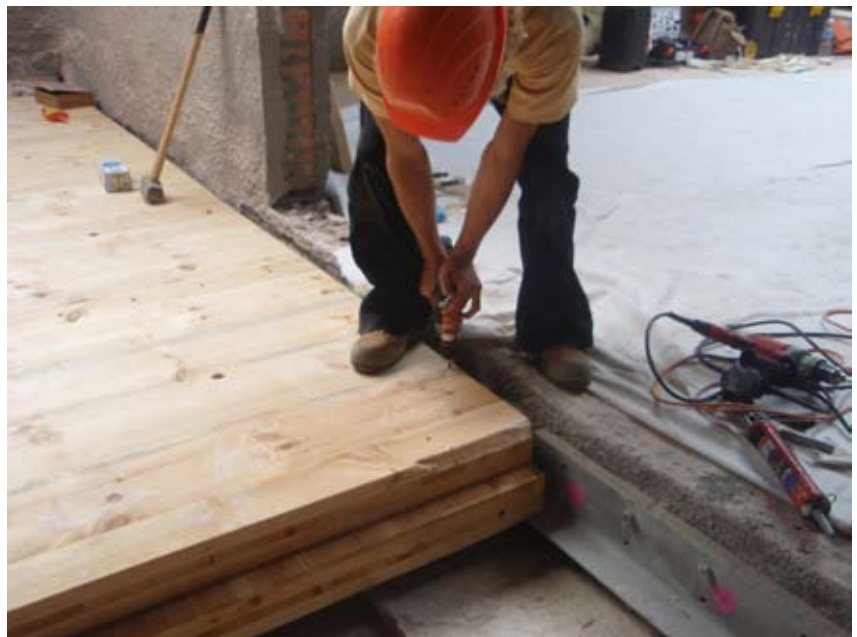
Ejecución de la conexión entre los tableros de madera en contacto y entre los tableros de madera y el perfil de apoyo. Fotos: S. Bestraten
