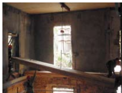
Proceso de montaje. Grúas y poleas colgadas siempre del forjado superior ya consolidado. Fotos: S. Bestraten
