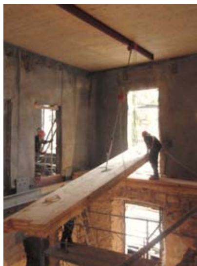
Proceso de montaje. Grúas y poleas colgadas siempre del forjado superior ya consolidado. Fotos: S. Bestraten
