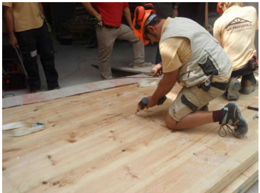
Ejecución de la conexión entre los tableros de madera en contacto y entre los tableros de madera y el perfil de apoyo. Fotos: S. Bestraten
