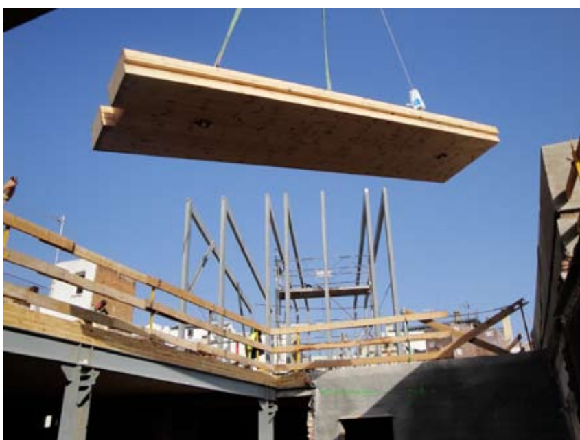
Proceso de montaje. Colocación mediante grúa, del forjado superior. Foto: S. Bestraten
