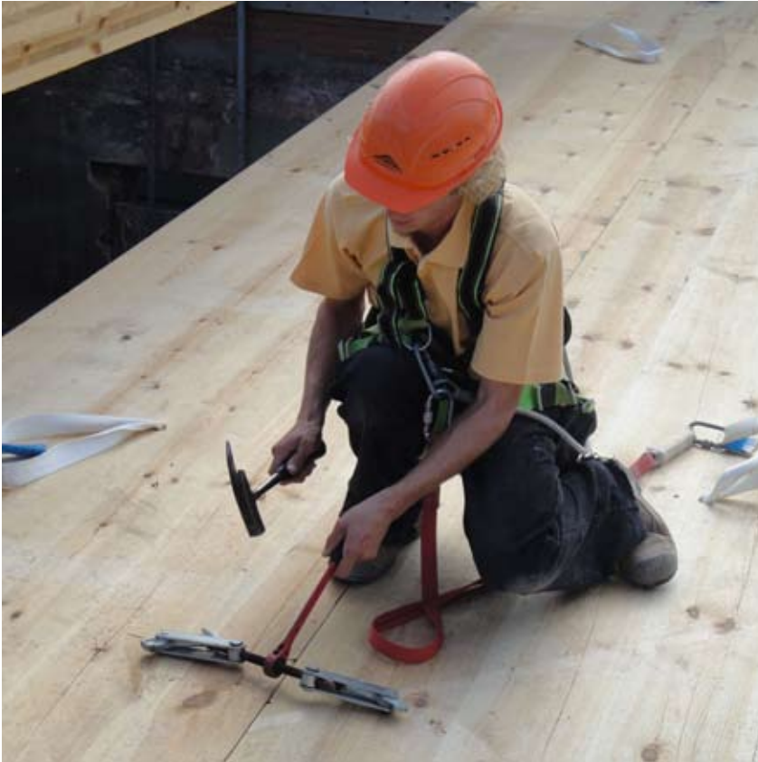
Proceso de montaje. El arnés se asegura fácilmente a cualquier punto del forjado. Foto: S. Bestraten
