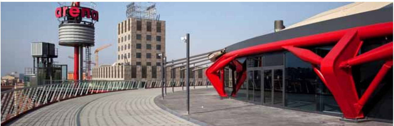
Detalle del estribo de tracción (un anillo de 46 cm de diámetro y 2 cm de espesor) que descansa sobre pilares acodados
