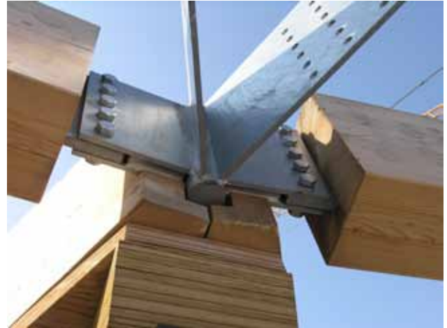
Estado de la estructura durante su paralización donde se aprecian los herrajes en los nodos de la malla triangulada
