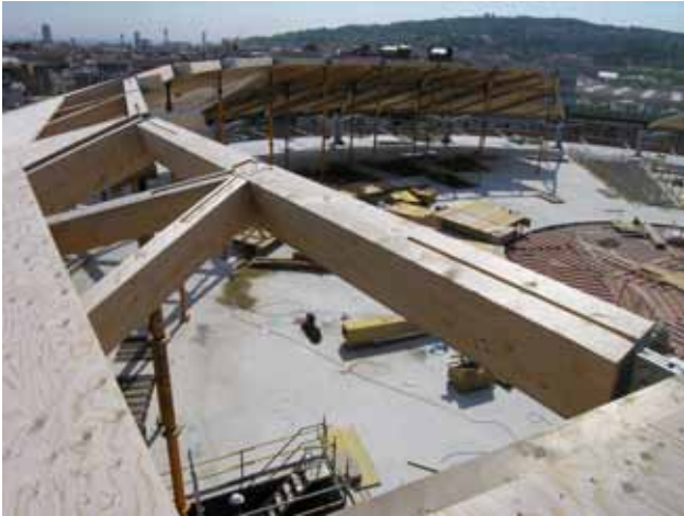
Estado de la estructura durante su paralización donde se aprecian los herrajes en los nodos de la malla triangulada
