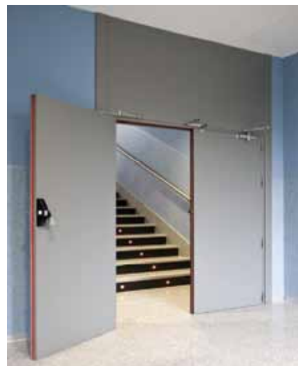
Salida emergencia EI 60
